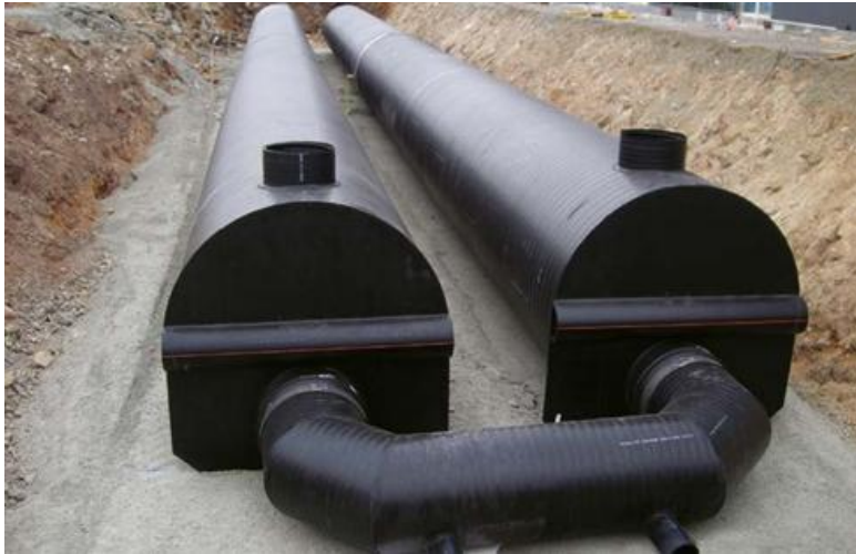
Kuvat 18. Esimerkki tonttikohtaisesta suuremman mittaluokan hulevesisäiliöstä hulevesien viivytykseen ja varastointiin (Weholite, Uponor Oyj)
