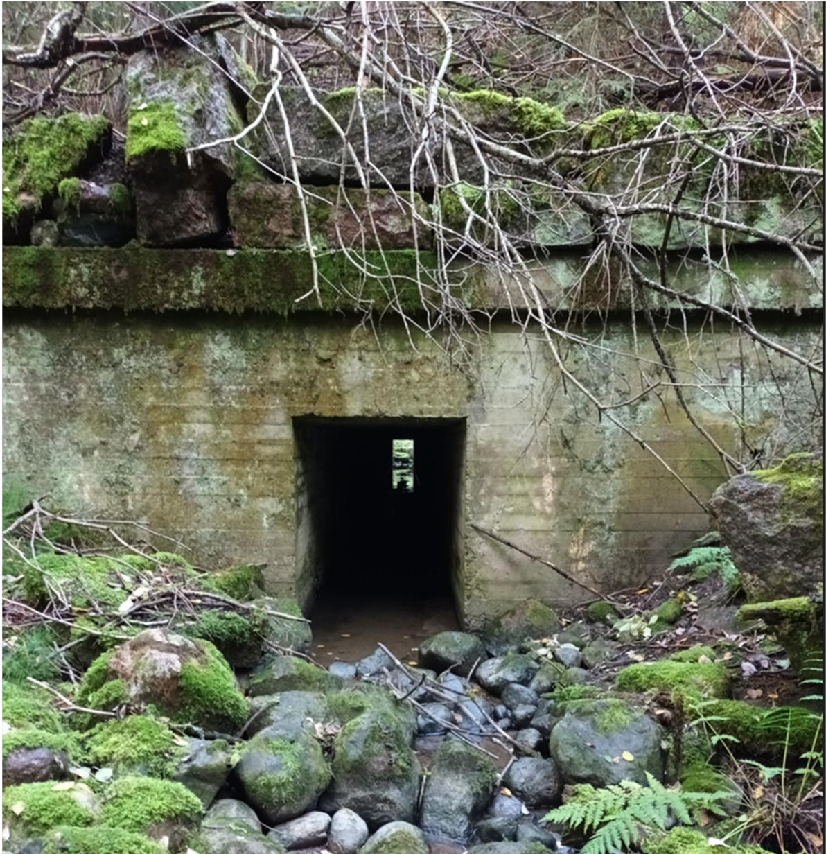
Kuva 9. Lahti-Loviisan alittava ratarumpu alajuoksulta päin katsottuna. (Ramboll 20.9.2024)
