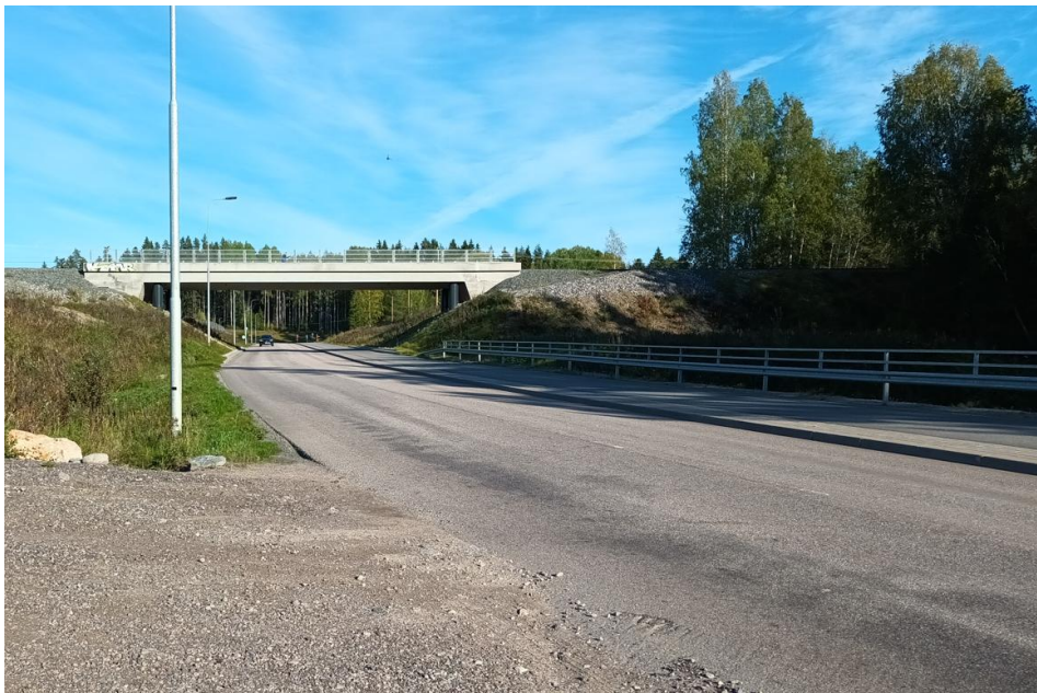
Kuva 4. Vanhanradankatu lännestä itään katsottuna. Kuvan keskellä Lahti-Loviisa rautatiesilta. (Ramboll 20.9.2024)
