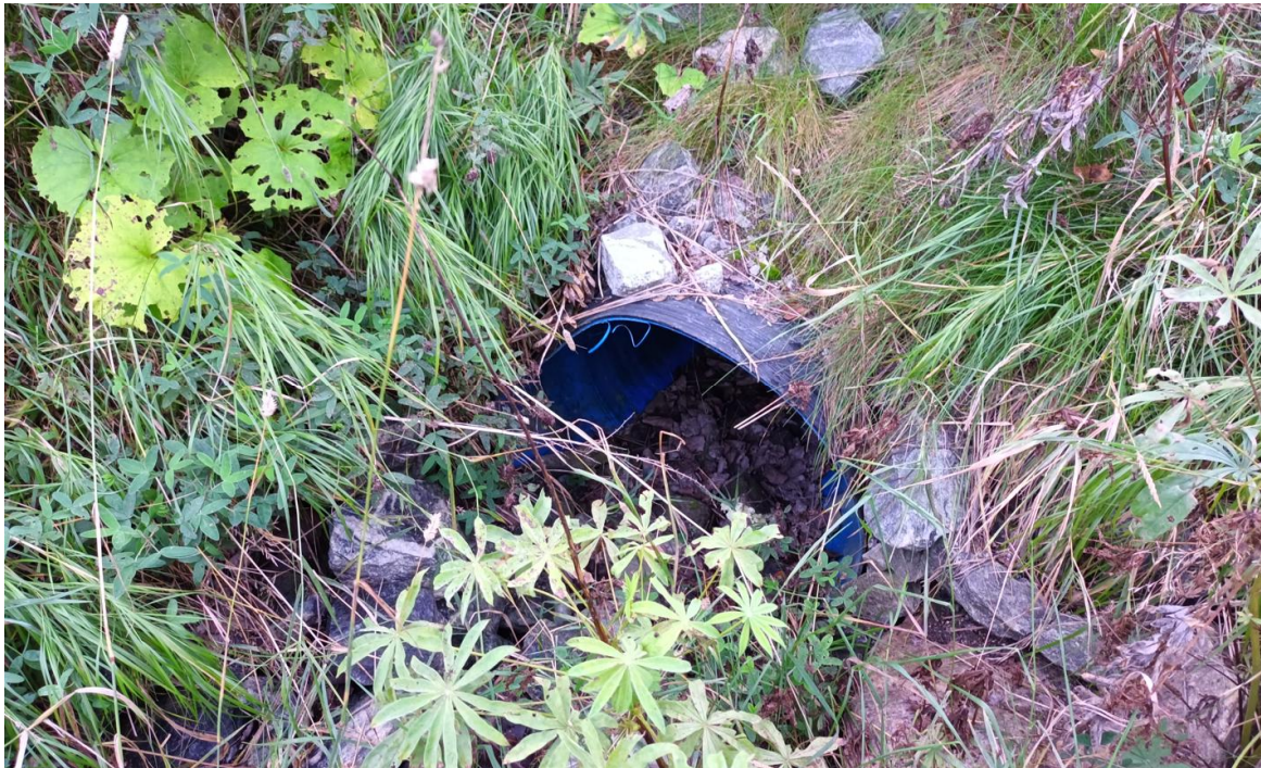
Kuva 8. Vanhanradankadun alittavan Ø 600 mm muovisen rumpuputken ottopää. Purkupää on piilossa kivien alla. (Ramboll 20.9.2024)
