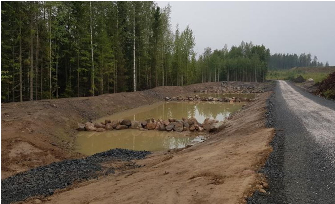
Kuva 16. Teollisuusalueen työnaikainen ja käyttöön jäävä hulevesiallas (Ramboll 2019)
