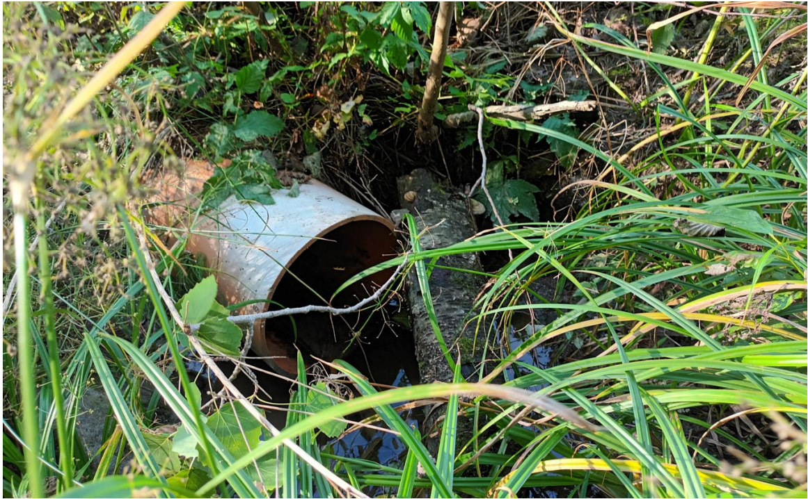
Kuva 7. Vanhanradankadun viistosti alittavan Ø 400 mm muovisen rumpuputken ottopää. (Ramboll 20.9.2024)
