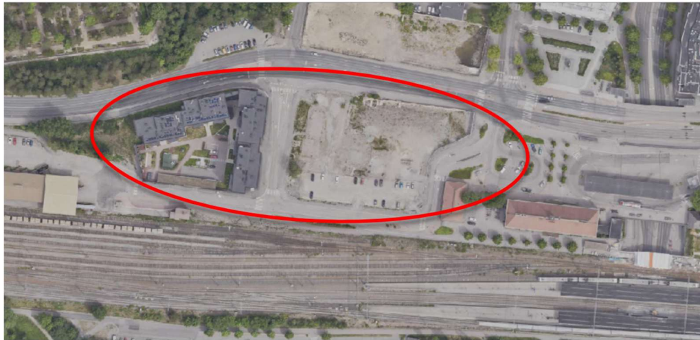
Kuva 1. Ortokuva alueesta, jossa vasemmalla valmiiksi rakennettu kortteli 166 (A-2846 Kaavaseloste)
