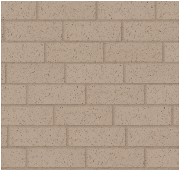
Julkisivun tiilimuurauksessa sävyeroja
