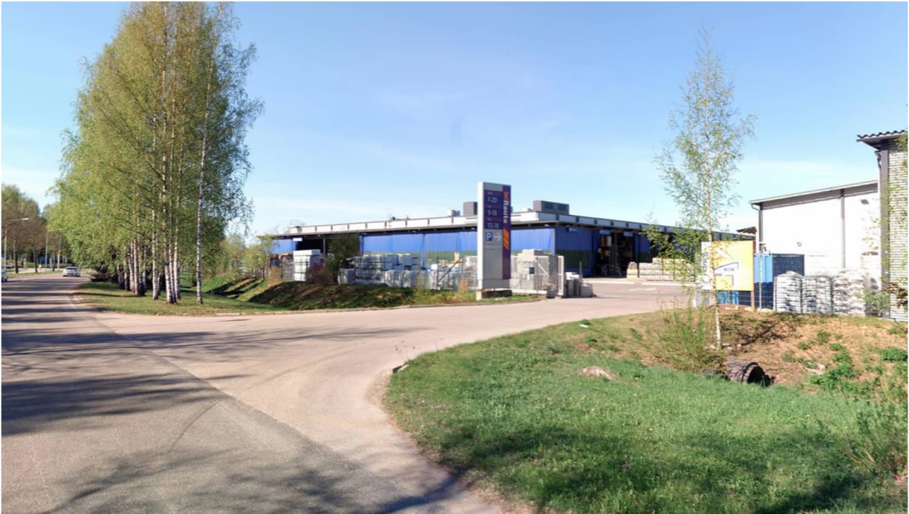
Ajokadun puoleinen liittymä ja Paskurinojan uoma keväällä 2024.
