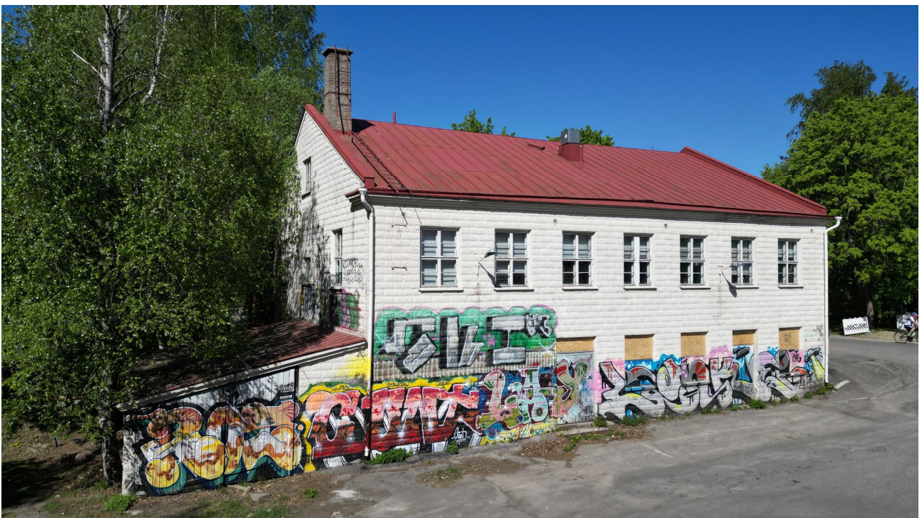
Lännen puoleinen rakennus piha-alueelta kuvattuna (kuva: Pasi Widgren).
