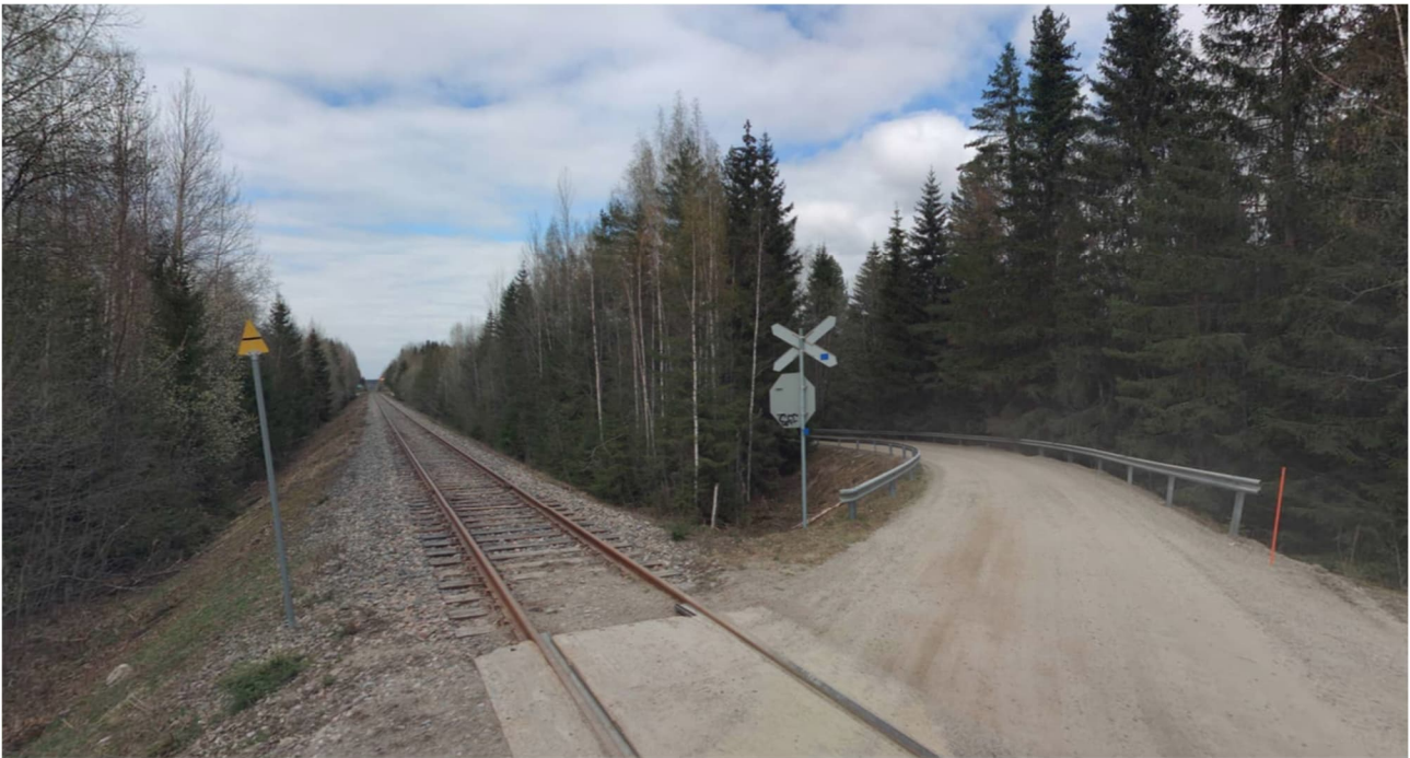
Näkymä suunnittelualan eteläpuolelta Lakkilantien tasoristeyksestä kohti pohjoista (toukokuu 2024).
