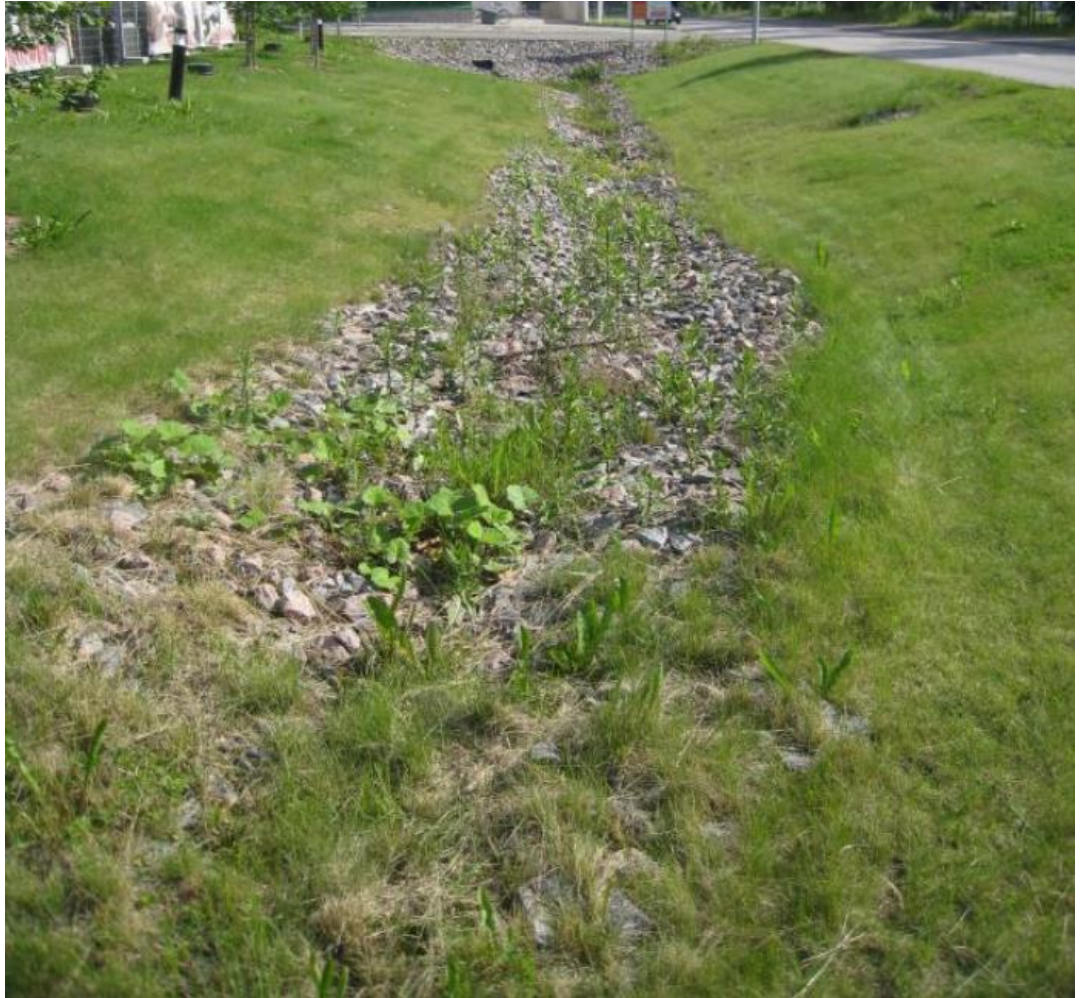
Kuva 8: Esimerkki hulevesiä viivyttävästä painanteesta.[3]
