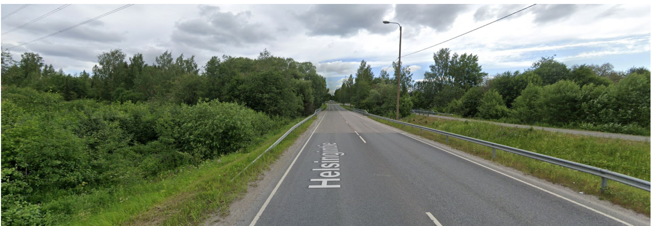
Näkymä Porvoonjoen sillan kohdalta pohjoiseen.
