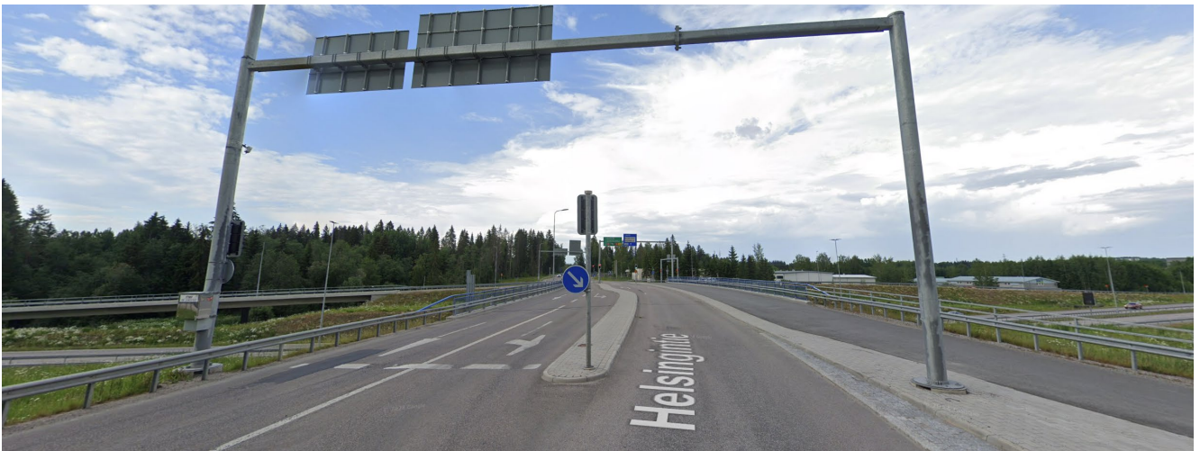
Näkymä Eteläisen Kehätien eritasoristeyksen kohdalta pohjoiseen.
