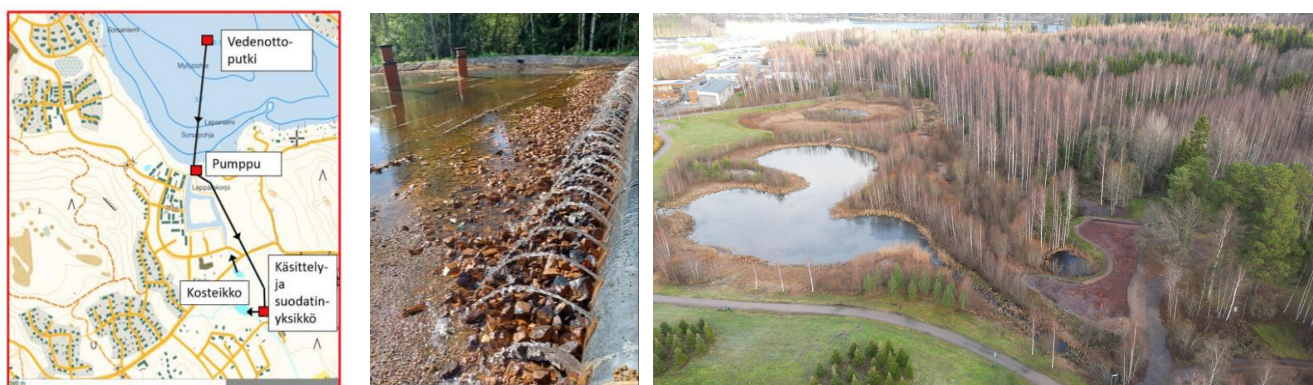
Kuva 4. Kymijärven alusvedenkäsittelyjärjestelmän sijainti vasemmalla. Keskellä suodattimen alkupää. Oikealla ilmakuva nykyisestä suodatinjärjestelmästä ja sen jälkeisestä hulevesijärjestelmästä, minkä kautta puhdistettu vesi palautetaan Kymijärveen.
