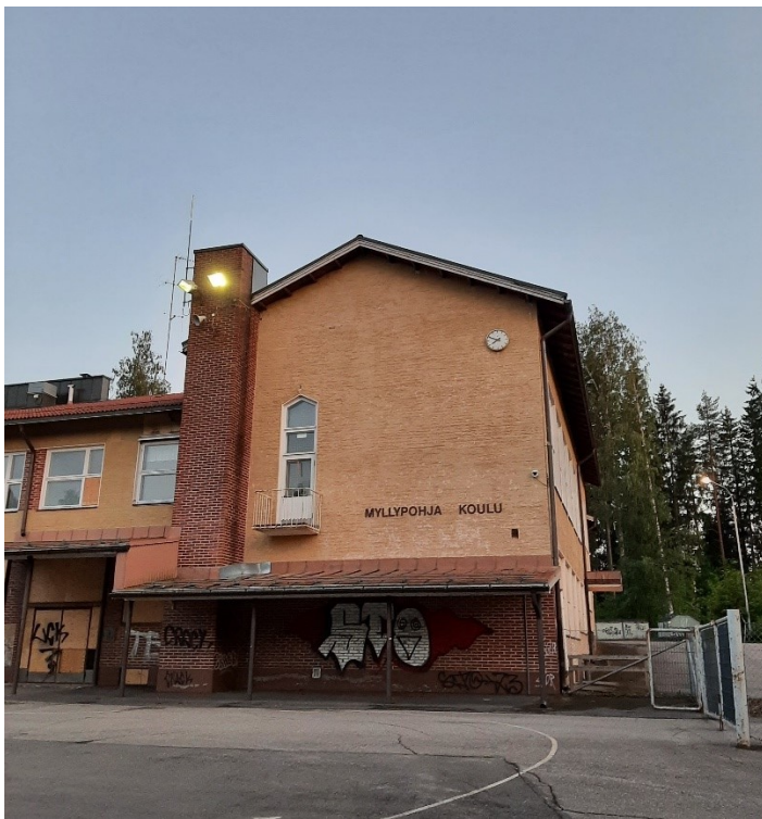
Kuva 5. Koulurakennuksen pääty, jonka räystäään alla tervapääskyjen sisäänmenoaukot sijaitsevat.
