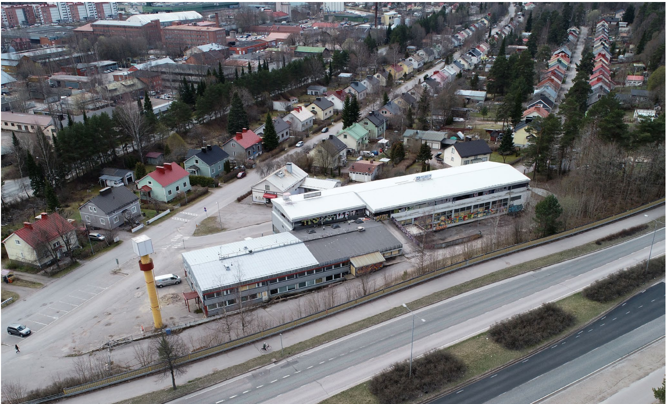
Kuva 5. Viistokuva Hämeenlinnantien suunnasta. Takana näkyy kulttuurihistoriallisesti arvokas Okeroistentien ja Vuotiankadun pientaloalue sekä Sopenkorven teollisuusalue.
