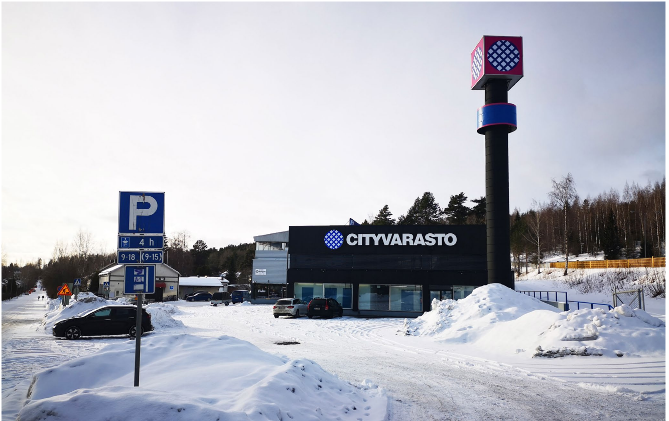
Kuva 6. Okeroistentie 1 helmikuussa 2024. Rakennuksen itäosan julkisivua ja mainospylonia on kunnostettu ja ne on maalattu Cityvaraston tunnusvärein.
