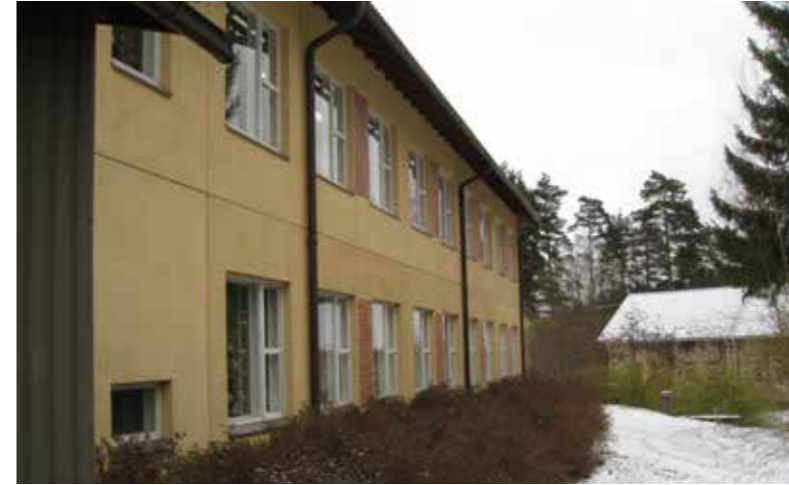
Kuva 56. Laajennuksen länsiseinää luoteesta.
