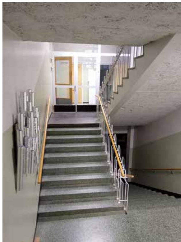
Kuva 13. Portaikkoa pohjakerroksesta kohti liikuntasalin ovea.
