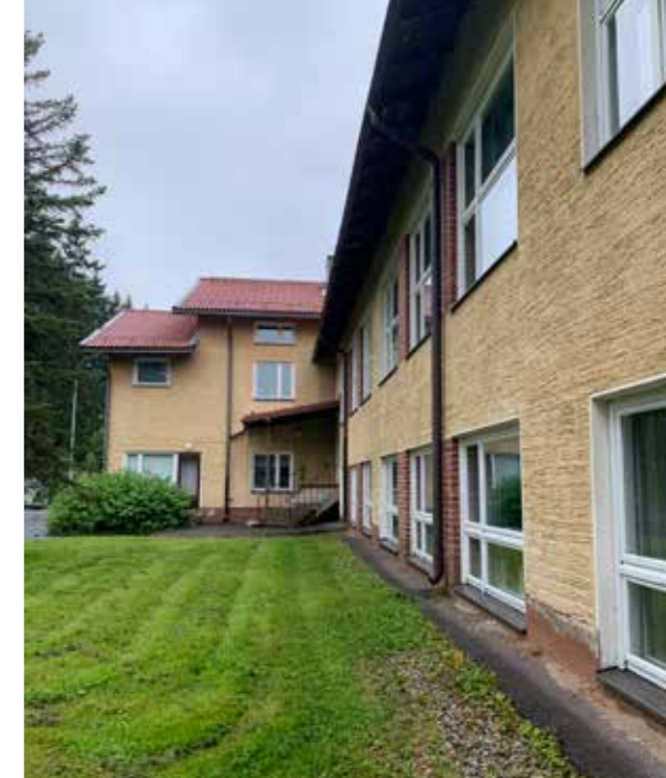
Kuva 18. Koulun vanhan osan julkisivua lännen puolelta.
