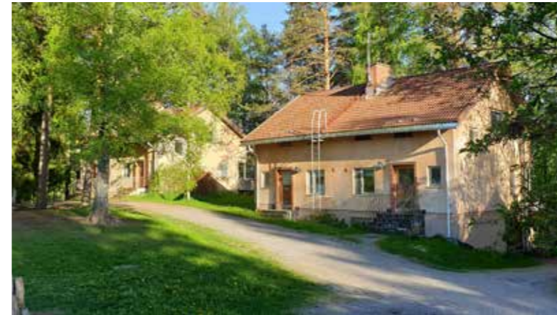
Kuva 25. Opettajien asuintaloja rakennuksen B1 ja B2.
