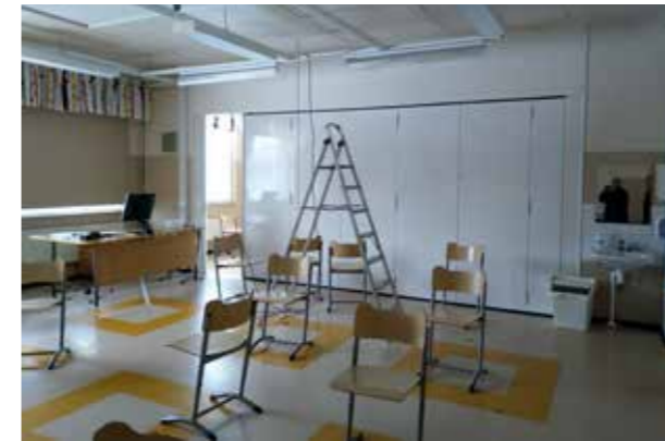
Kuva 57. Siirtoseinä kahden luokkatilan välissä.
