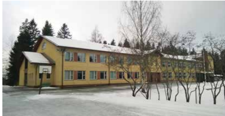
Kuva 54. Koulu laajennuksen jälkeen lännestä.
