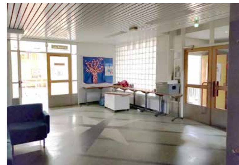
Kuva 63. Pääsisäänkäynnin aulan ominaispiirteitä, kuten lasitiiliseinä, mosaiikkibetonilattia. Tilallisena heikennyksenä on metallinen alakatto.
