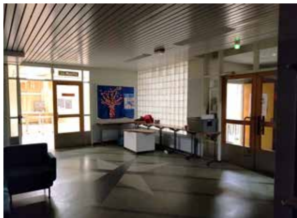
Kuva 12. Aula, jossa alaslaskettu katto laajennuksen ajalta.
