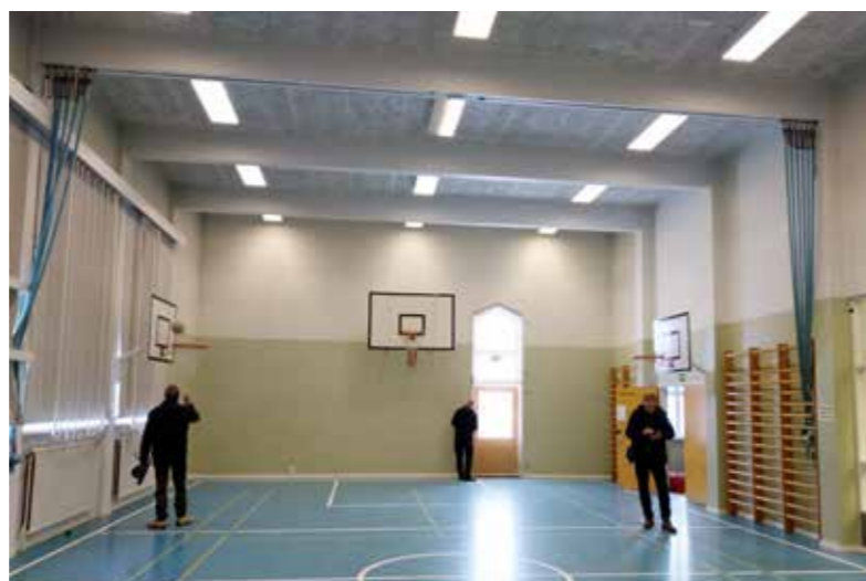
Kuva 20. Liikuntasalin pilareita ja palkkeja.
