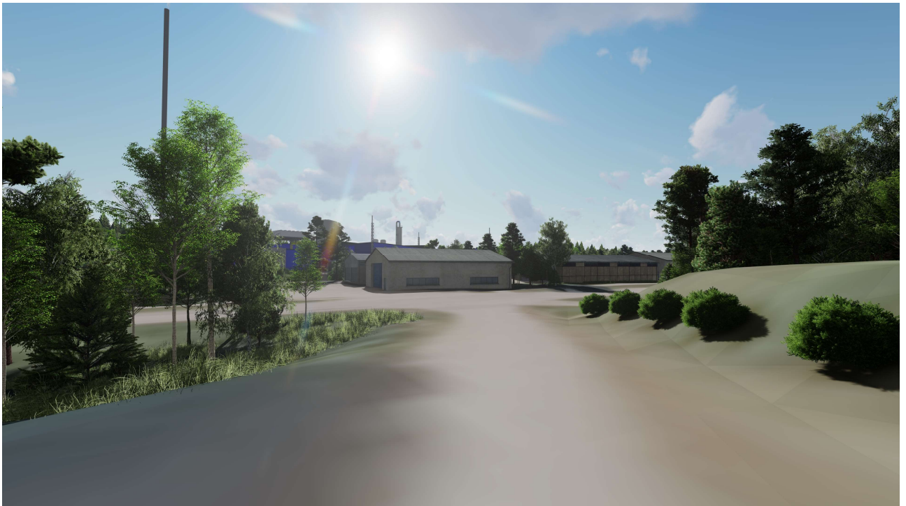
Havainnekuva 6: Kuva Kahvakadulta tuotantolaitoksen suuntaan, näkymä silmänkorkeudelta Kahvapuiston eteläpäädyssä.
