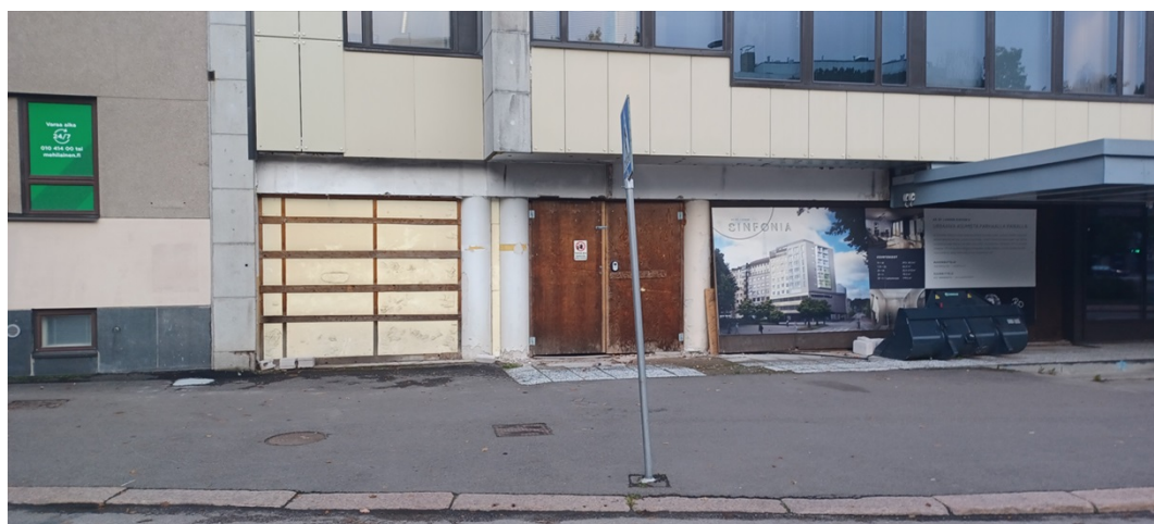
Kuva 1. Siistittävä ja kunnostettava osa rakennusta. Sisäänkäynti ympäristöineen on rakennettava valmiiksi.
