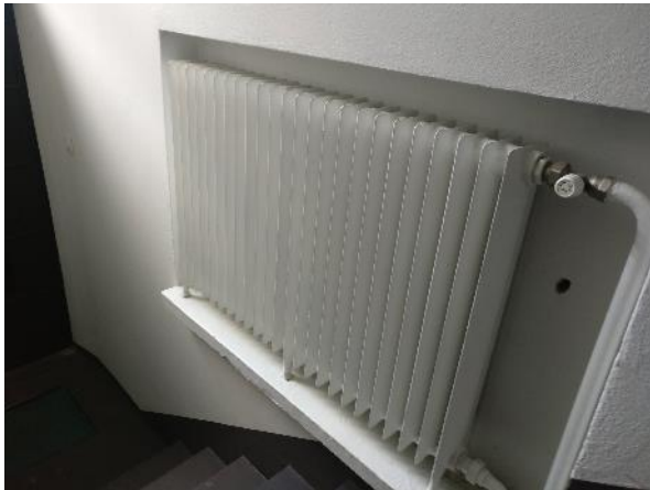
Kuva 40: Lämmityspatteri.
