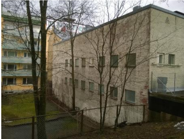
Kuva 4: Läntistä julkisivua, joka rajoittuu viereiseen tonttiin.
