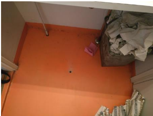
Kuva 16: Toisen kerroksen wc-tilan lattiaa.
