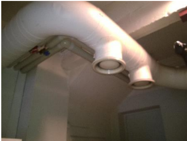
Kuva 36: Poistoilmaventtiileitä autotallitiloissa.
