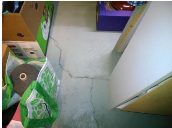
Kuva 13: Alapohjarakenteissa halkeilua.
