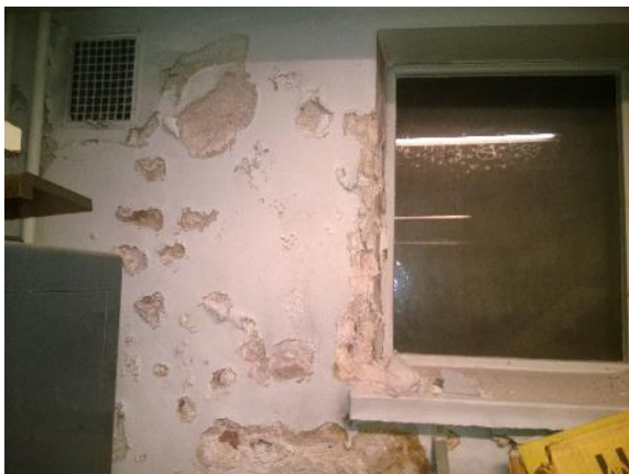
Kuva 22: Ensimmäisen kerroksen yhden autotallin ulkoseinää.
