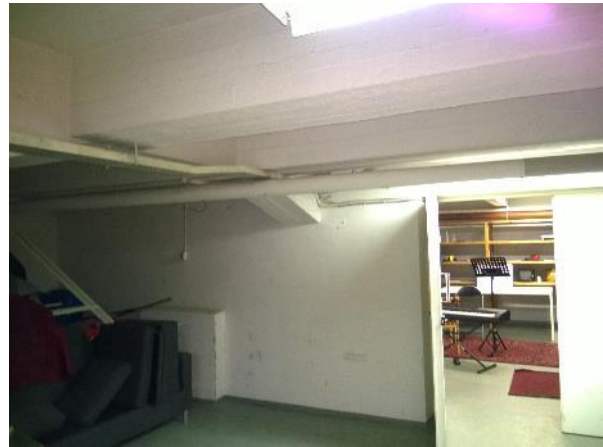
Kuva 25: Betonirakenteinen väliseinä ensimmäisessä kellarikerroksessa.
