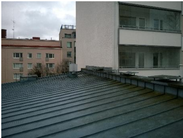
Kuva 29: Itäisen siiven vesikattoa, yläräystäällä hormistoja.
