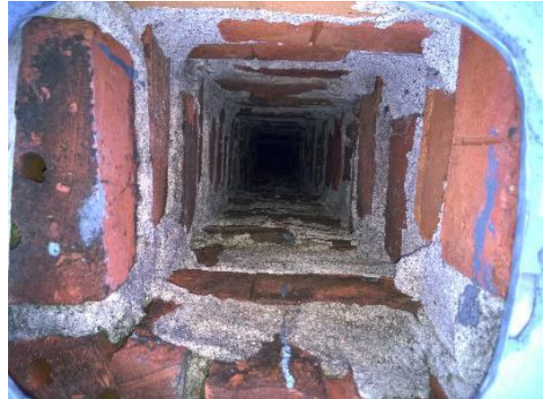
Kuva 35: Rakennusaineinen poistohormi.
