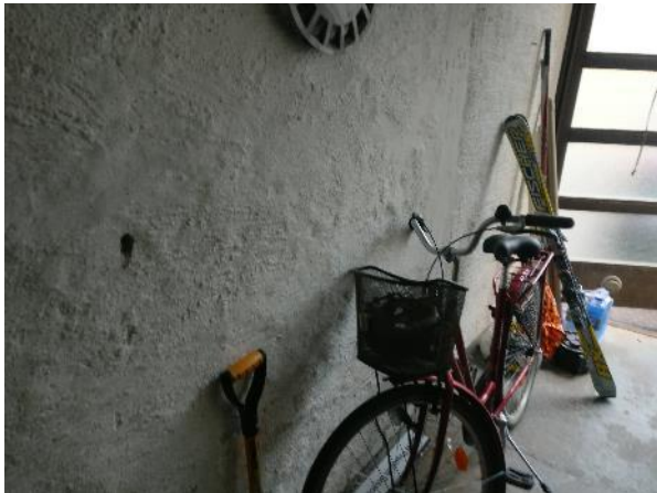
Kuva 24: Tiilirakenteinen väliseinä pohjoispäädyn autotallissa.
