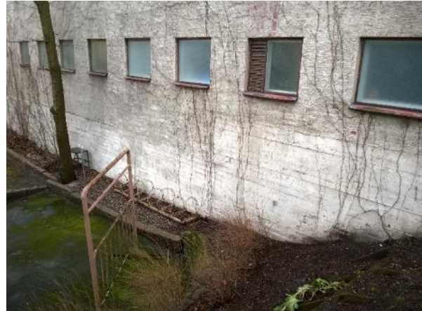
Kuva 5: Läntisen julkisivun maanpinnat ovat nurmipintaisia ja vierustalla kasvaa puustoa.
