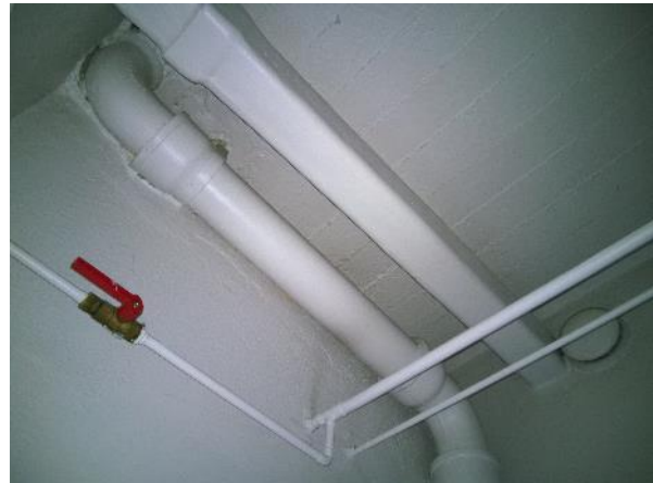
Kuva 41: Rakennusaikainen valurautaviemäri.
