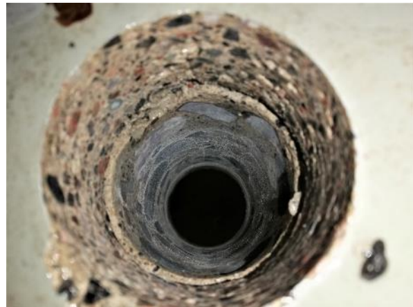
Kuva 19: Eteläsiiven kolmannesta autotallista kerätyn näytteen näytteenottoreikä. Kantavassa laatasta havaittavissa suurehkoja kiviä (PUR5).
