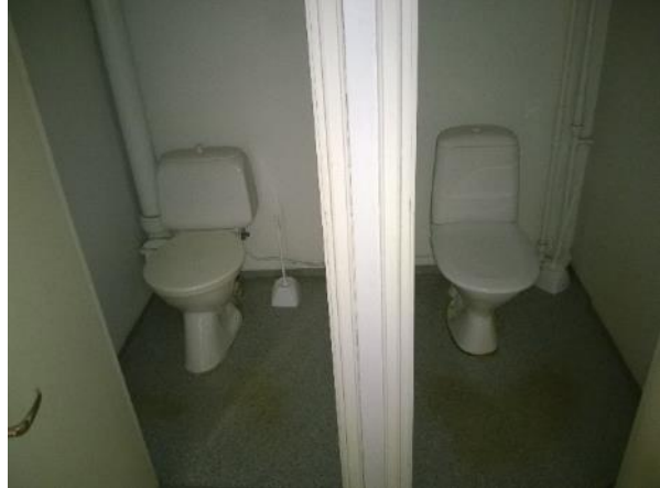
Kuva 15: Ensimmäisen kerroksen wc-tila.
