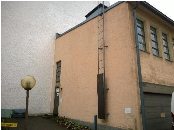
Kuva 31: Räystäskourua ja syöksytorvea.
