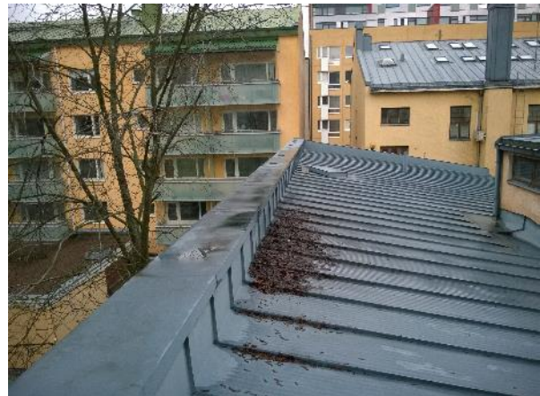
Kuva 30: Pohjoissiiven vesikattoa, yläräystäällä hormistoja.
