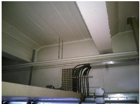
Kuva 17: Ensimmäisen ja toisen kerroksen välipohjarakenteita.
