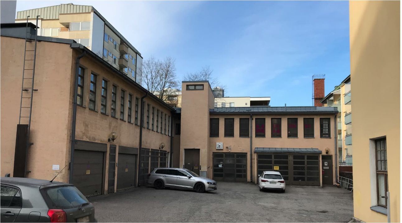
Kuva 6. Näkymä piharakennukselle sisäpihalta.
