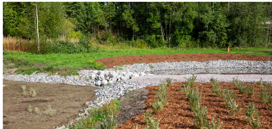
Kuva 8. Hulevesien imeytys Hennalassa.
