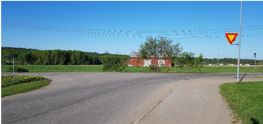
Kuva1. Työmaatie lähtee Lepomäentien ja Metsä-Pekkalantien liittymästä. Liittymäkohdassa on tarkistettava ilmajohtojen korkeus suhteessa työmaatiehen. Työmaatien liittymä on varustettava merkillä 232 pakollinen pysäyttäminen.
