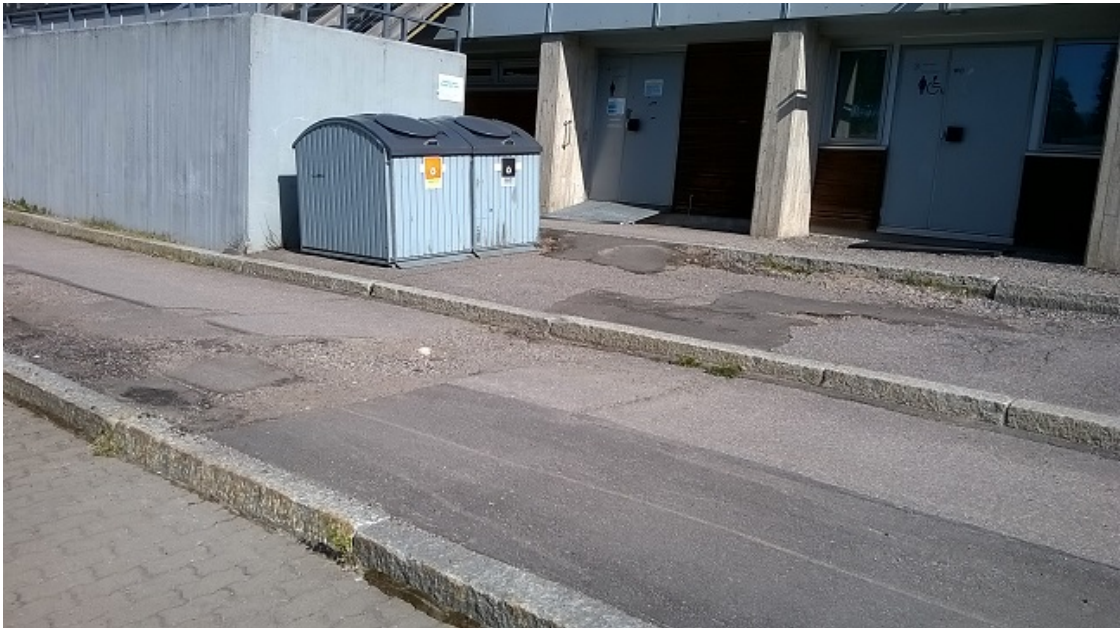
Kuva 4. Kuva Liikuntatilojen edustalta. Huom. 3-tasoisuus.
