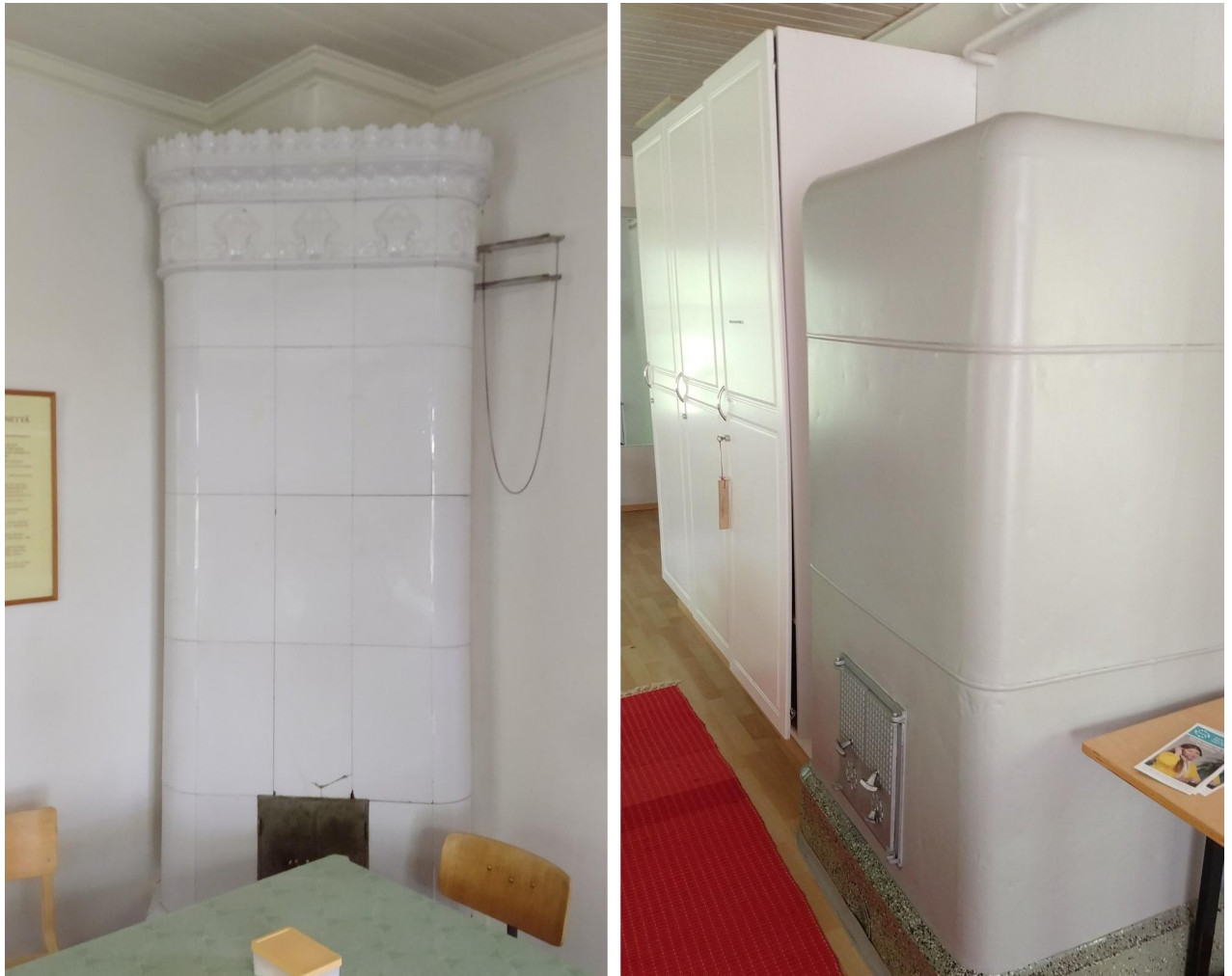
Kuva 11 Kuvapari päärakennuksen säilytettävistä uuneista. Vasemmalla ensimmäisen kerroksen kaakeliuuni ja oikealla kellarikerroksen eli entisen verstaan uuni.
