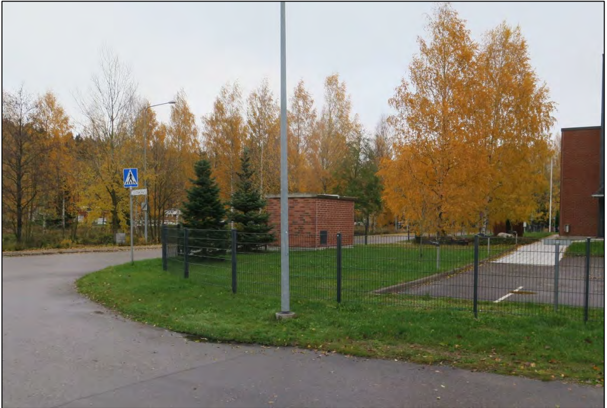
Kuva 3. Pelastuslaitoksen aita ja sähkökeskus Veistämönkadun ja Telakkakadun liittymässä. Lavettiyhdistelmän kääntyminen edellyttää lisätilan järjestämistä sisä- ja/tai ulkokaarteesta.
