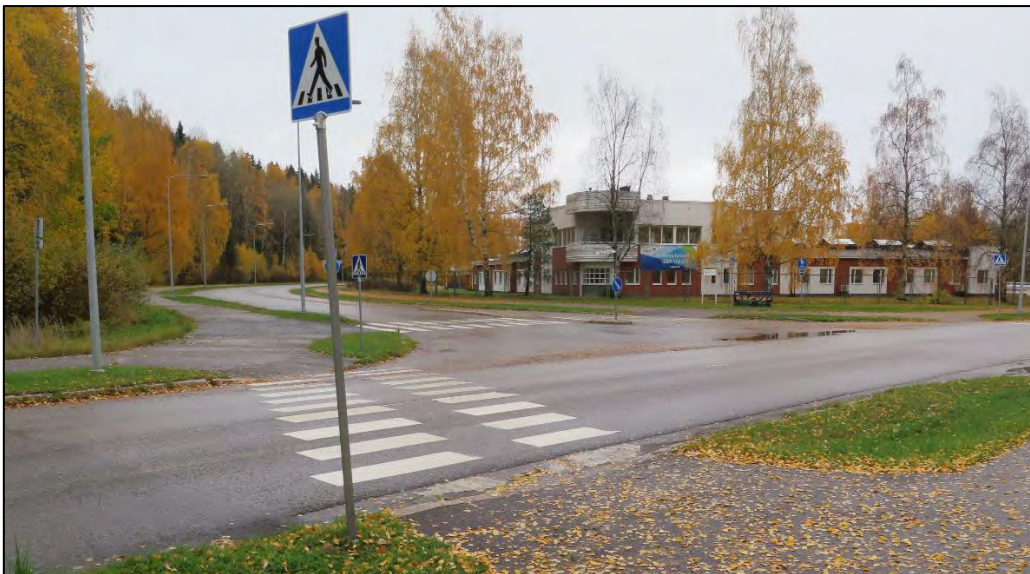
Kuva 1. Niemenkadun ja Haapalankadun liittymä. Lavettiyhdistelmät saapuvat Haapalankadun
