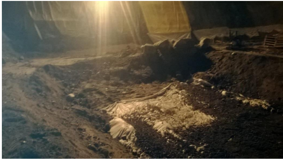
Kuva 6. Suodatinkangas pisteen JP196 kohdalta.
