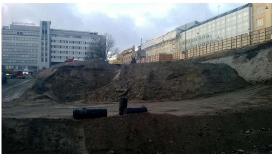
Kuva 4. Yleiskuva työmaalta torikadun suunnalta.
