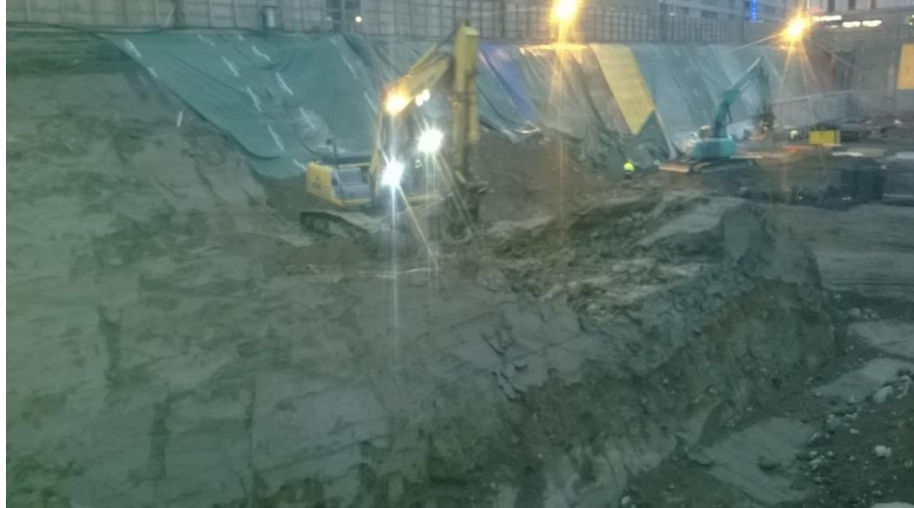
Kuva 4. Pilaantuneen maan kaivuu anturalinjan 3 kohdalla.
