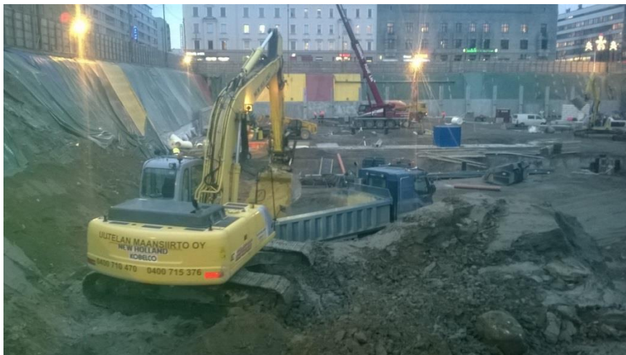
Kuva 3. Pilaantuneen maan kuormaus kaupatorilla.
