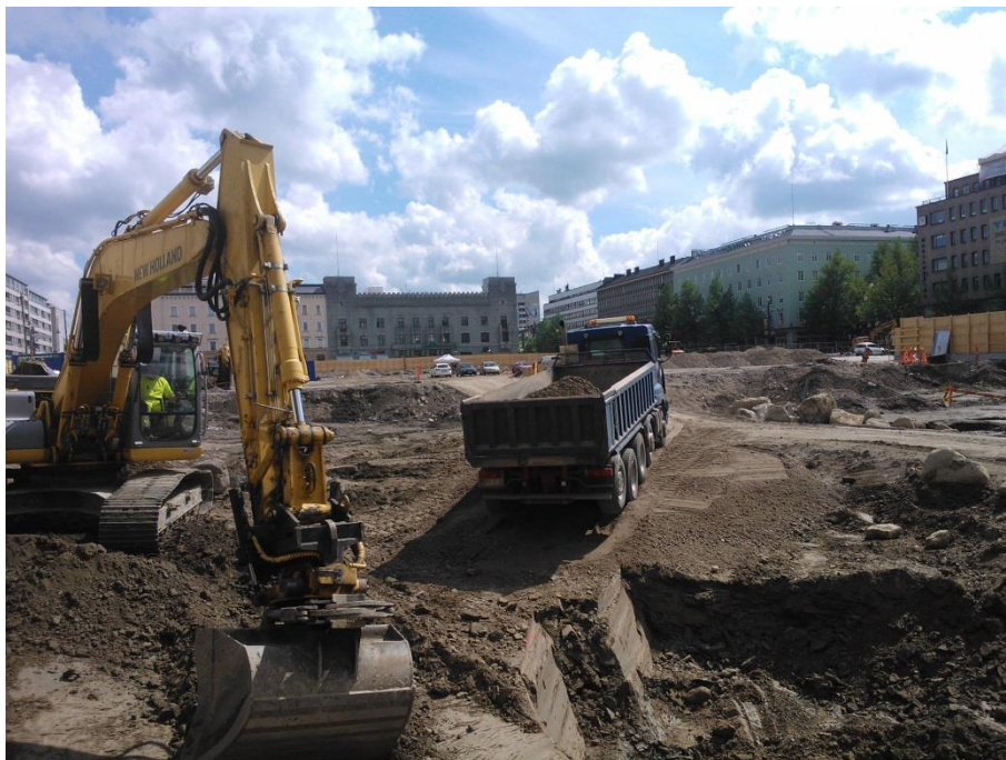
Kuva 2. Pilaantuneen maan kuormaus alatorilla.
