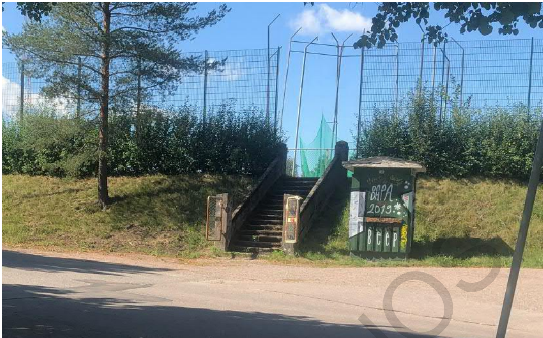
Kuva 12. Itäpäädyn kunnostettavat portaat
