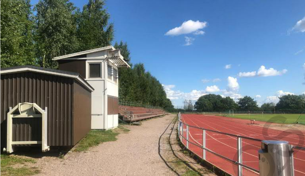
Kuva 7. Nykyinen kuuluttamo ja varastokontti
