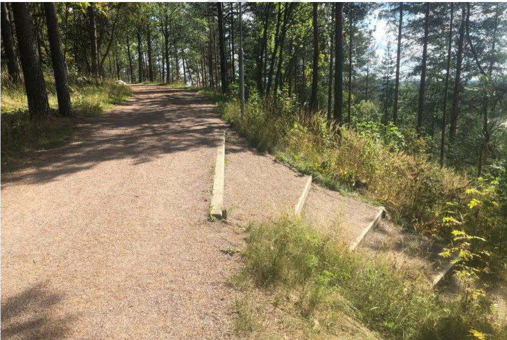
Kuva 17. Ulkoilureitin kunnostettava porras
