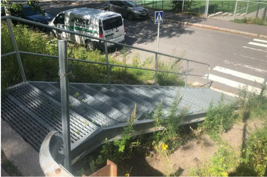
Kuva 14. Harjukadun ja Elielinkadun väliset portaat
