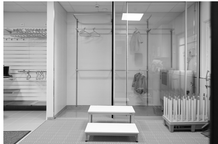
Kuivauskaappi lasiliukuovilla, käsi-kuivain, pukemispenkki, tuulikaappimatto paikallarakennetussa lattiasyvennyksessä joka toimii samalla kurasyöppönä.
