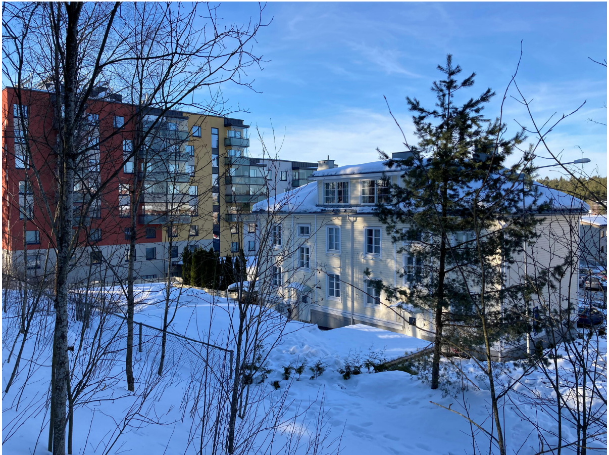
Kuva korjatun ja asunnoiksi muutetun Lounaankatu 2:n päärakennuksesta Lotilanharjunrinteestä kuvattuna helmikuussa 2022.
