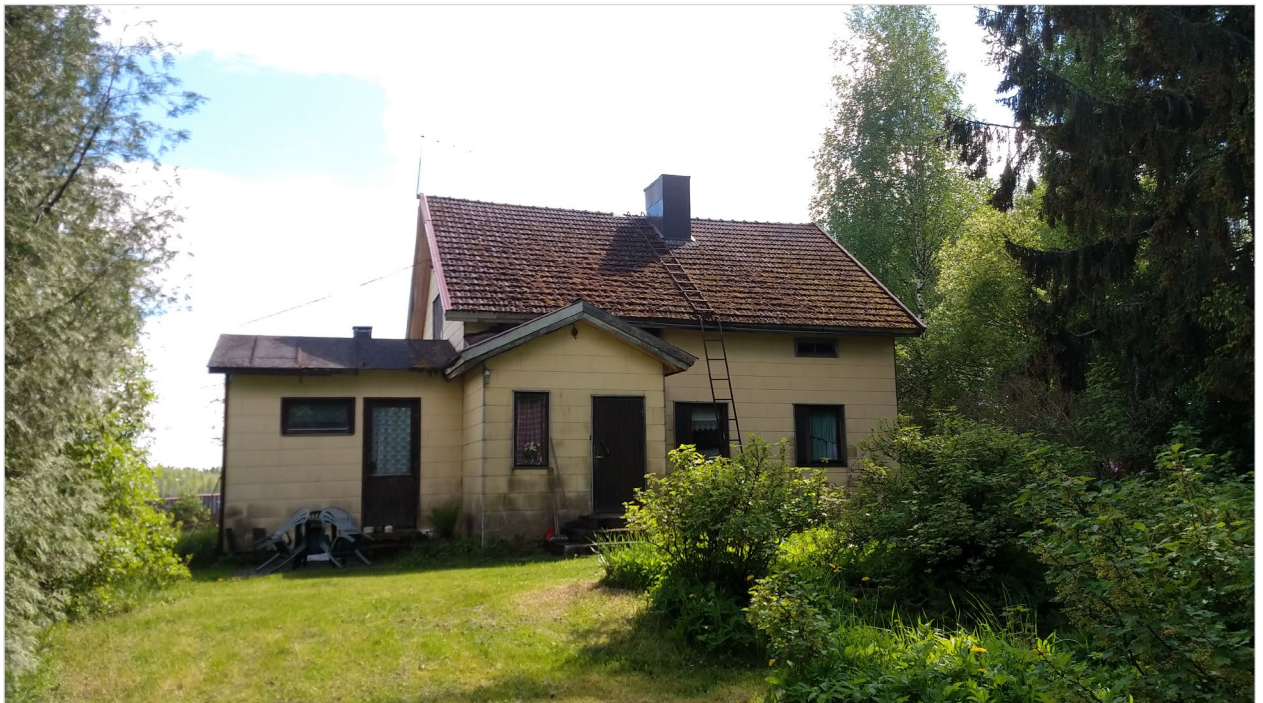
Kuva 3 Alueella oleva rintamamiestalo pohjoispuolelta kuvattuna.
