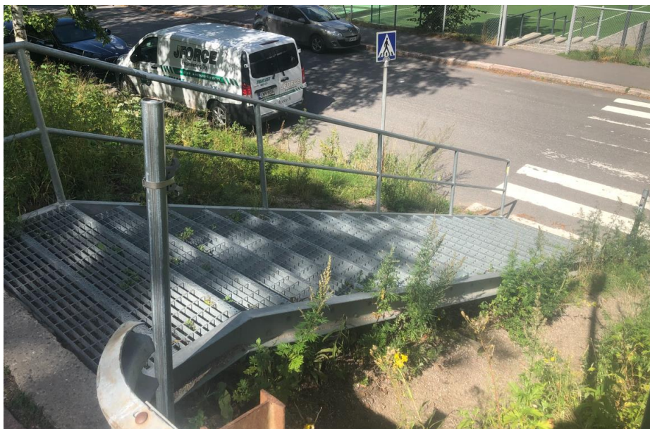
Kuva 14. Harjukadun ja Elielinkadun väliset portaat
