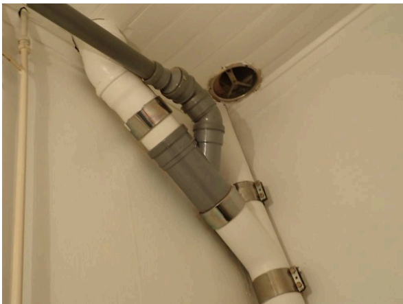
80. Yläkerran viemäriä lisätty.
