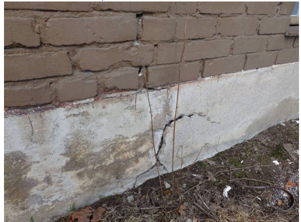
18. Perustukset ja sokkelit
