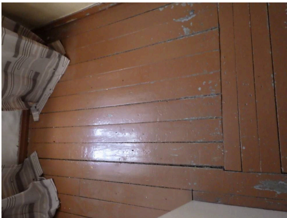
45. Lattia on vanhalle rakennukselle tyypillinen. Lattia ei ole suora.
