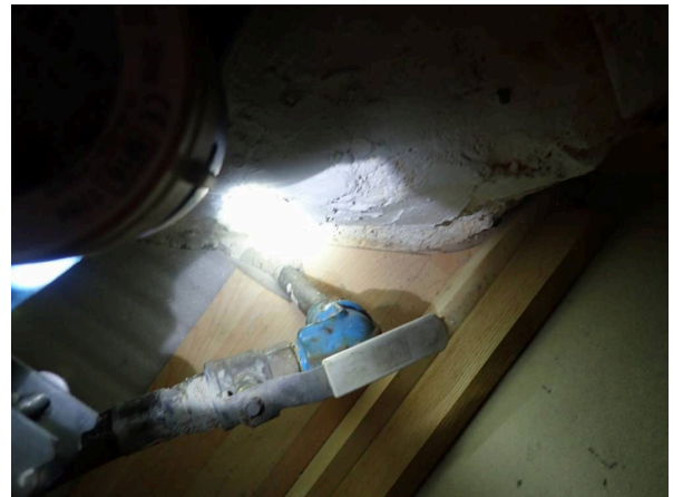
72. Tonttivesijohto uusittua muoviputkea.
