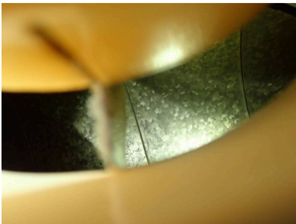
93. Kanava varsin puhdas koneellisen ilmanvaihdon alueella.
