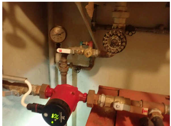
62. Päärungon linjasäätöventtiili uusittu.
