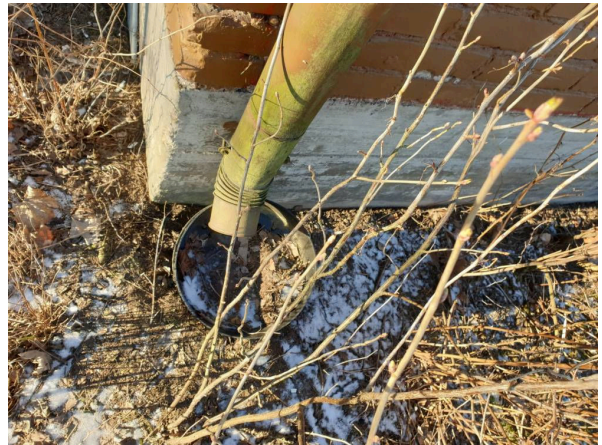
5. Syöksytorvet ja rännikaivot kaipaavat puhdistusta ja huoltoa
