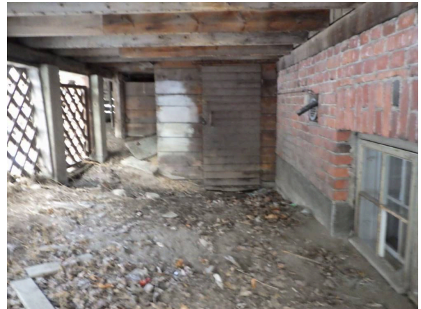
34. Terassin alapuolisia rakenteita.
