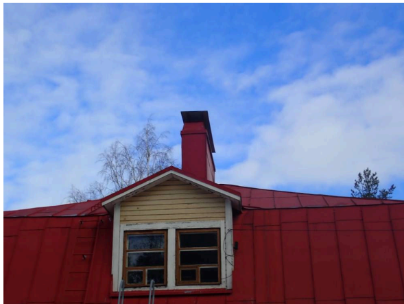
90. Painovoimaisen ilmanvaihdon hormipiipun päällä on sadehattu.
