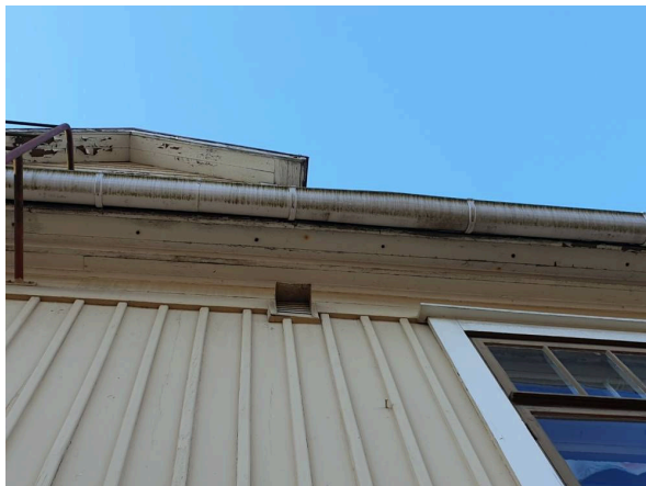
39. Rästäs rakenteeseen on porattu reikiä tuuletuksen parantamiseksi.
