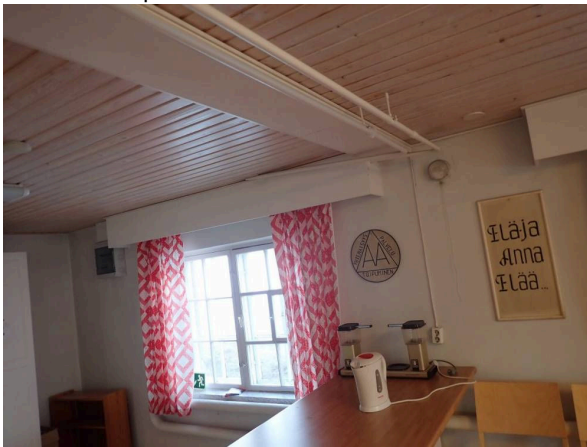
68. Lämpölinjat kulkevat pääosin näkyvillä.
