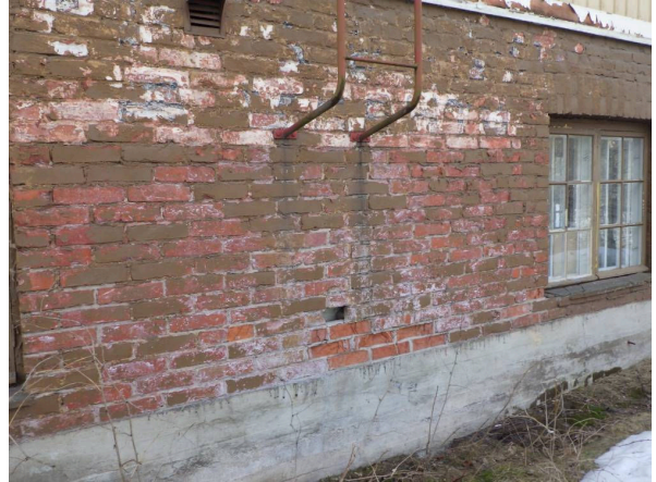
16. Perustukset ja sokkelit
