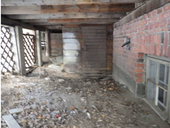
15. Perustukset ja sokkelit
