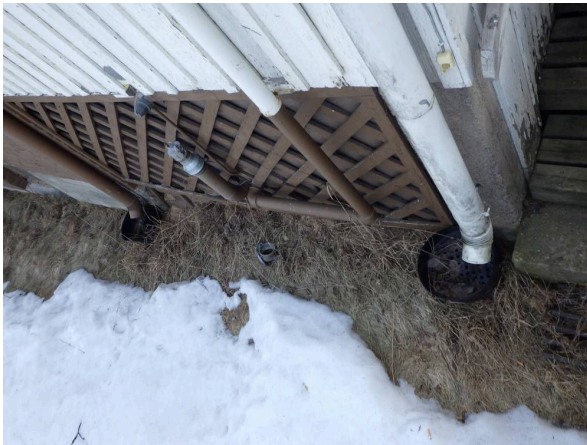
4. Rakennuksen vierustaa ja rännikaivoa
