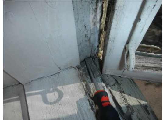
Osa rukoushuoneen ikkunoista on huonossa kunnossa, puuosissa on lahoa ja maalaus lohkeilee irti.
