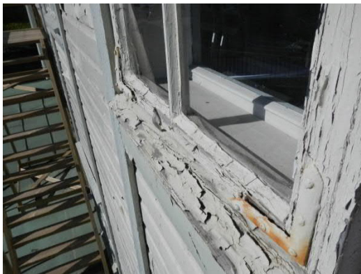
Osa rukoushuoneen ikkunoista on huonossa kunnossa, puuosissa on lahoa ja maalaus lohkeilee irti.
