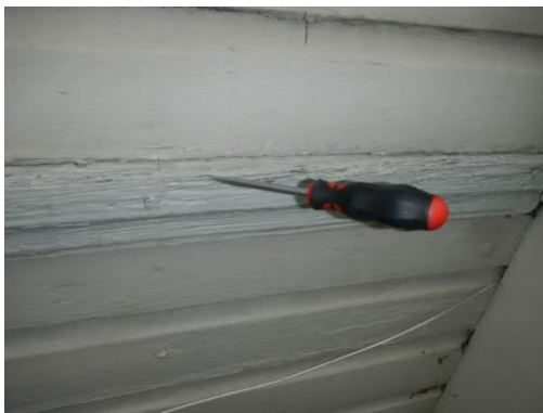
Rukoushuoneen seinän maalaus lohkeilee, paikoitellen puu on lahoa tai pinta on pehmeää.
