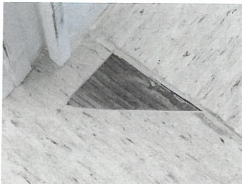
Kuva 2. Liima tummunut muovimaton alla.
