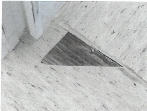
Kuva 2. Liima tummunut muovimaton alla.
