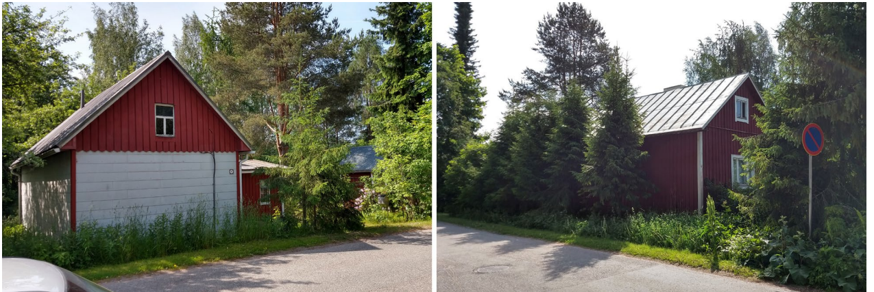
Kuva 3 Kuvissa näkyy Sippolankatu 8:n rakennuskantaa.
