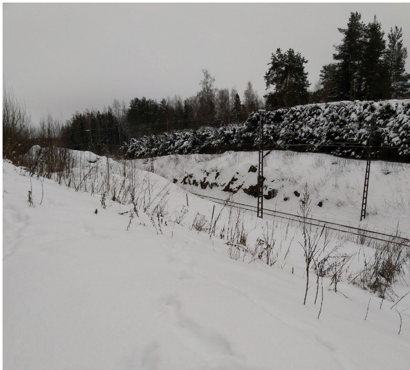
Suunnittelualueen eteläreunaan rakennettu meluvalli
