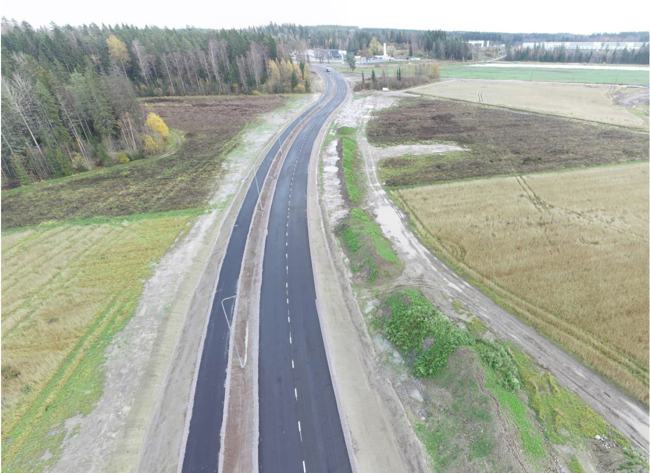
Kuva 2. Näkymä Kujalankatua pitkin pohjoiseen ja koilliseen (Valtari)
