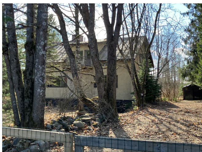
Kuvat: Koulun itäpuolelta purettuja asuinrakennuksia.
