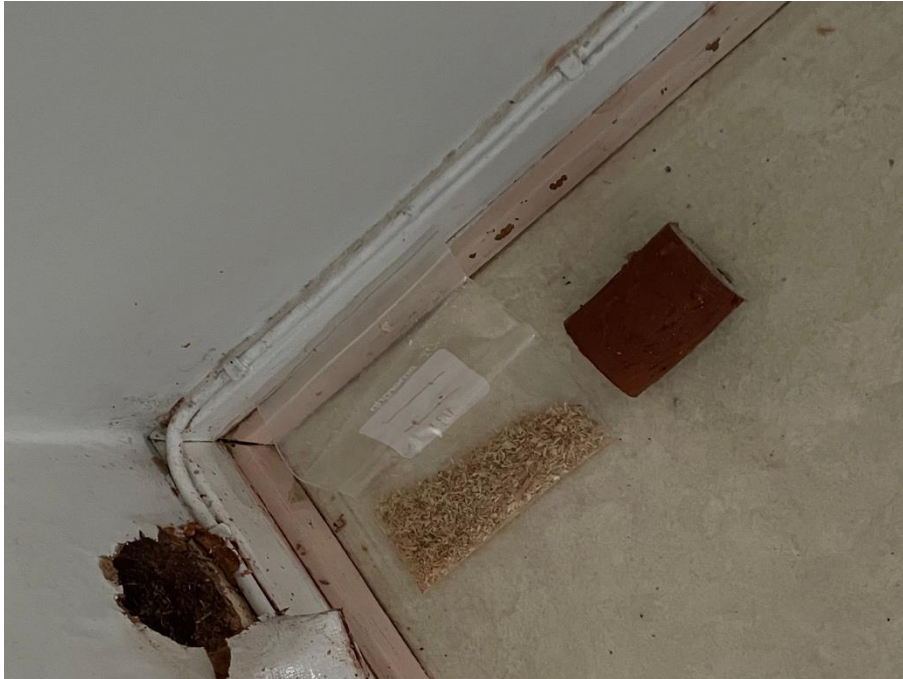
Kuva 5.5 Rakenneporaus olohuoneen ulkoseinään. Ulkoseinärakenteiden porauksen perusteella rakenteena on seinän sisäpuolelta alkaen selostuksen mukainen poltettu tiili ja sahanpurueriste. Porausten perusteella tiili on umpitiili.
