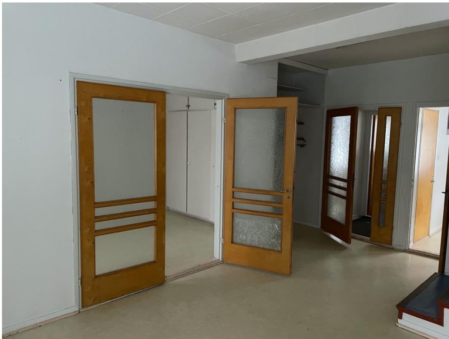
Kuva 5.4 1. kerroksen lattiat ovat muovimattopintaisia, rakennus on pääosin alkuperäisessä kunnossa.
