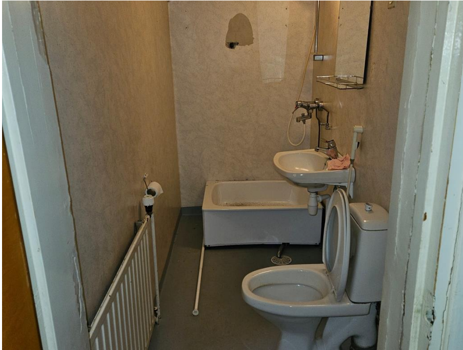
Kuva 5.11 Ullakolla on rakennuksen ainoa wc/pesutila, kuva asunnosta 2. Alkuperäisen laatoituksen päälle on asennettu muovitapetti.
