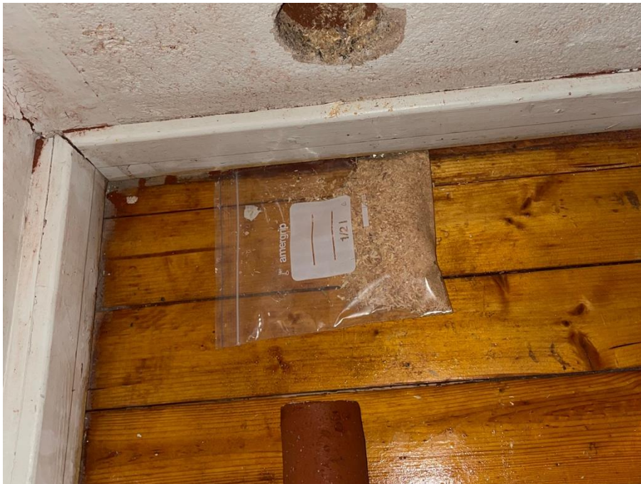
Kuva 5.8 Rakenneporaus ullakon makuuhuoneen ulkoseinään. Ulkoseinärakenteiden porauksen perusteella rakenteena on seinän sisäpuolelta alkaen selostuksen mukainen poltettu tiili ja sahanpurueriste. Porausien perusteella tiili on umpitiili.
