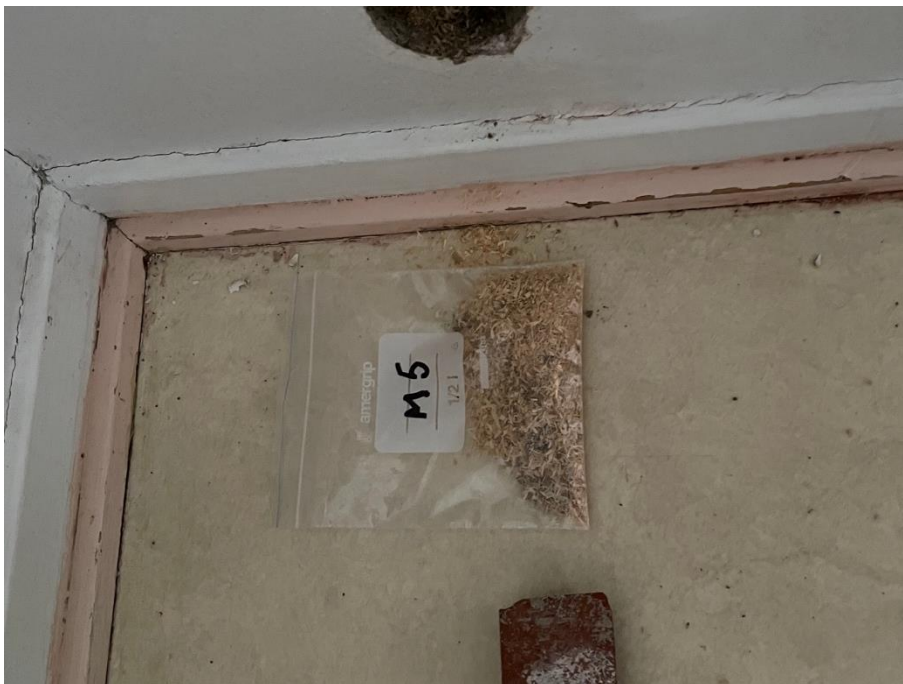
Kuva 5.6 Rakenneporaus keittiön ulkoseinään. Ulkoseinärakenteiden porauksen perusteella rakenteena on seinän sisäpuolelta alkaen selostuksen mukainen poltettu tiili ja sahanpurueriste. Porausten perusteella tiili on umpitiili.
