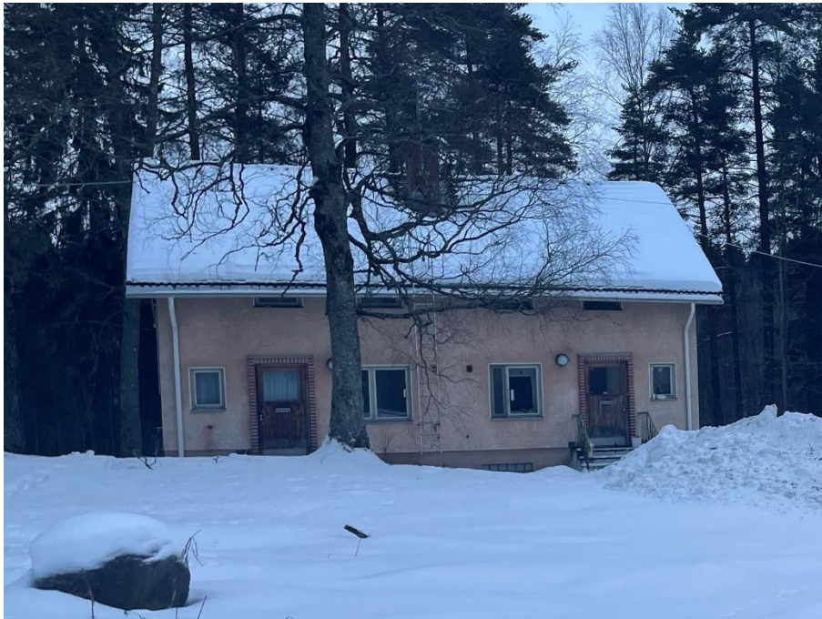
Kuva 5.2 B1- ja B2-talot ovat paritaloja, asunnot ovat 64 m 2 kokoisia toistensa peilikuvia. Ulkoseinärakenteena on rapattu tiilirakenteinen sahanpurueristetty seinä. Tiilestä on tehty lokeroita, joiden välissä on sahanpurueriste.
