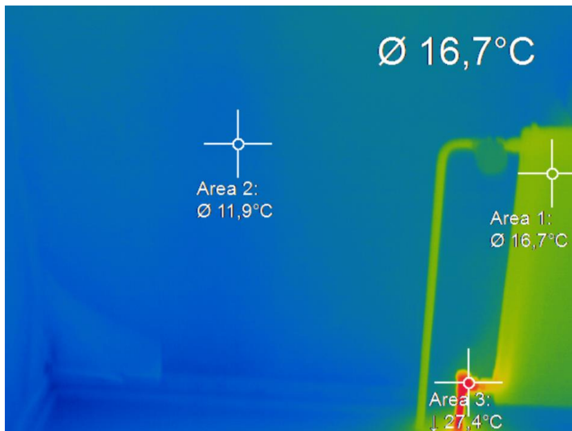
Kuva 5.28 A-talo asunto 3. 1. kerros, pieni makuuhuone. Lämpöpatteri ei ole toiminnassa ja pintalämpötilat ovat alhaiset.
