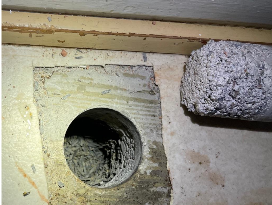
Kuva 5.13 1. kerroksen lattian avauksessa havaittiin välipohjan pintabetonivalun alla lämmöneristeenä olevan toja-levyä. Pintabetoni on tehty kahdesta erillisestä valukerroksesta, joista alempi on alkanut rapautumaan.
