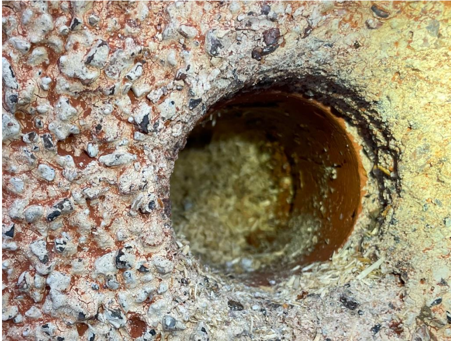
Kuva 5.3 Julkisivun rakenneavaus. Rappauksen takana on 85 mm poltettu umpitiili. Sahanpurueriste on kiinni tiilirakenteessa. Ulkopinnan rappaus estää jonkin verran tiilen kastumista, mutta on oletettavaa, että sahanpurueristeen ulkopinta kastuu tai ulkopintaan tiivistyy kosteutta.
