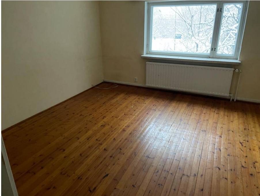
Kuva 5.7 Ullakkokerroksen makuuhuoneen lattiassa on puulaudoitus. Makuuhuoneen ympärillä on ullakkotiloja.
