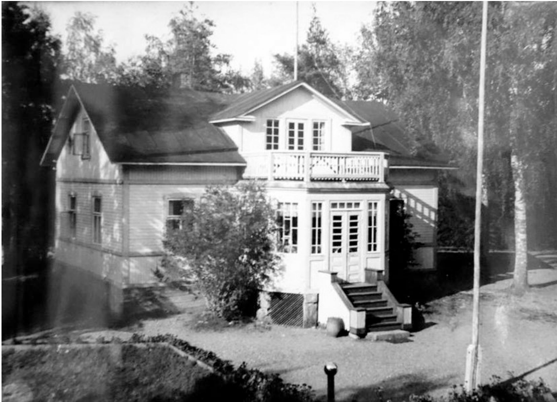
Huvila alkuperäisessä asussa ennen laajennusosaa.
