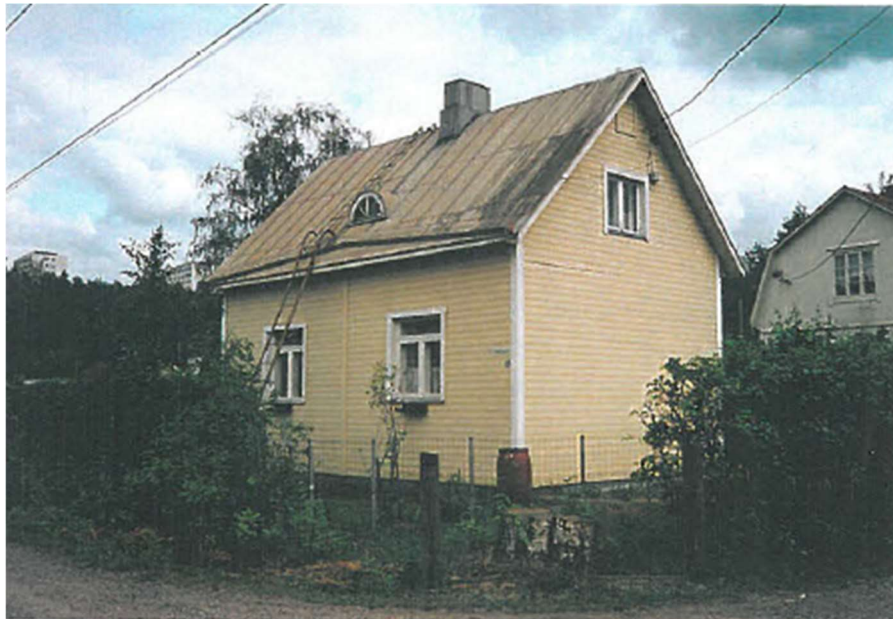
Kuva 7: Lepistön tilan vanha, joskaan ei aivan alkuperäinen päärakennus vuodelta 1935. Kuva Taka-Lotilan miljööselvityksestä, vuodelta 2000.
