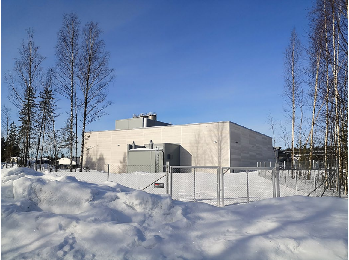
Wipakin laajennusosa maaliskuun alussa 2022.
